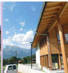
CRÈCHE MUTLI ACCUEIL Saint-Gervais-les-Bains (74) Architecte : Atelier Wolf & Associés (74) © Thomas Charmasson
