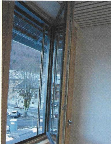
Les menuiseries extérieures sont en triple vitrage sur les façades nord, est, ouest et en double vitrage sur la façade sud.
