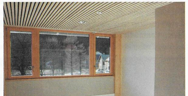
L'aménagement intérieur a été réalisé avec des panneaux trois plis en épicéa. Les plafonds des bureaux sont également parés de bois et ceux des couloirs de dalles en fibres de bois et magnésie.
