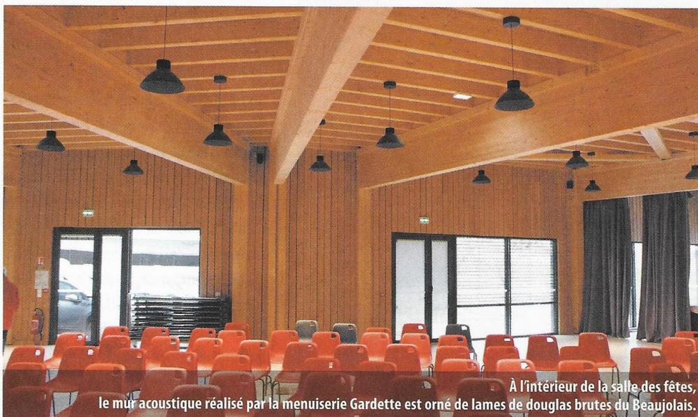
À l'intérieur de la salle des fêtes, le mur acoustique réalisé par la menuiserie Gardette est orné de lames de douglas brutes du Beaujolais.
