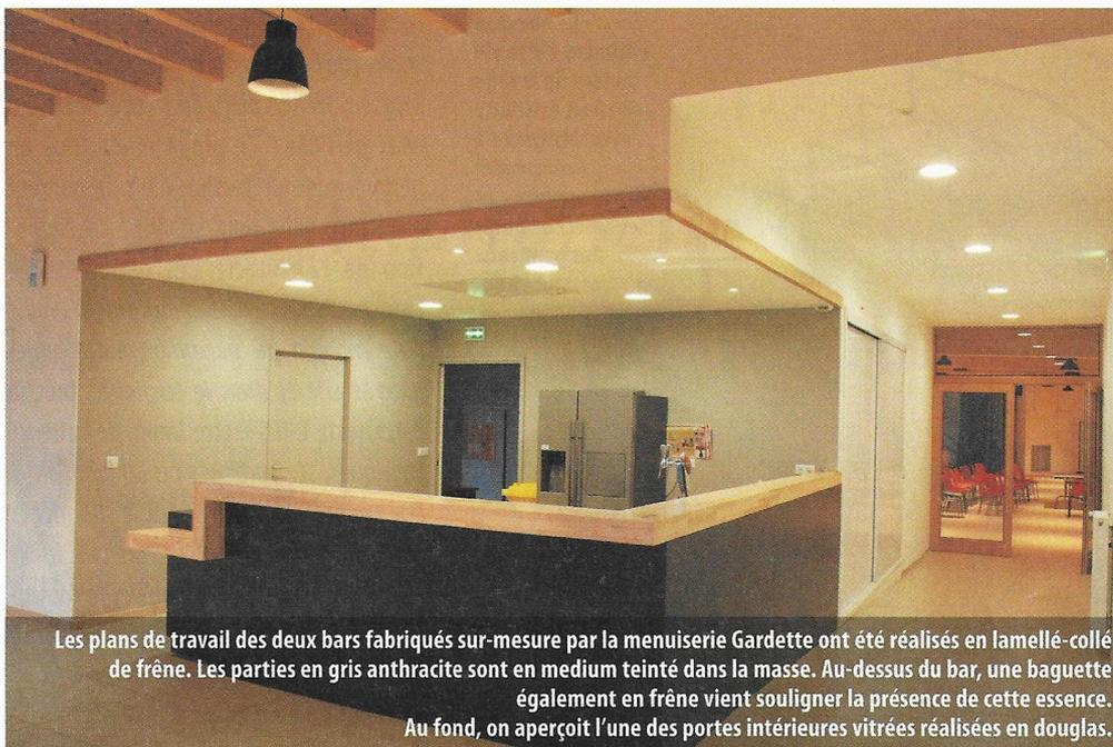
Les plans de travail des deux bars fabriqués sur-mesure par la menuiserie Gardette ont été réalisés en lamellé-collé de frêne. Les parties en gris anthracite sont en medium teinté dans la masse. Au-dessus du bar, une baguette également en frêne vient souligner la présence de cette essence. Au fond, on aperçoit l'une des portes intérieures vitrées réalisées en douglas.
