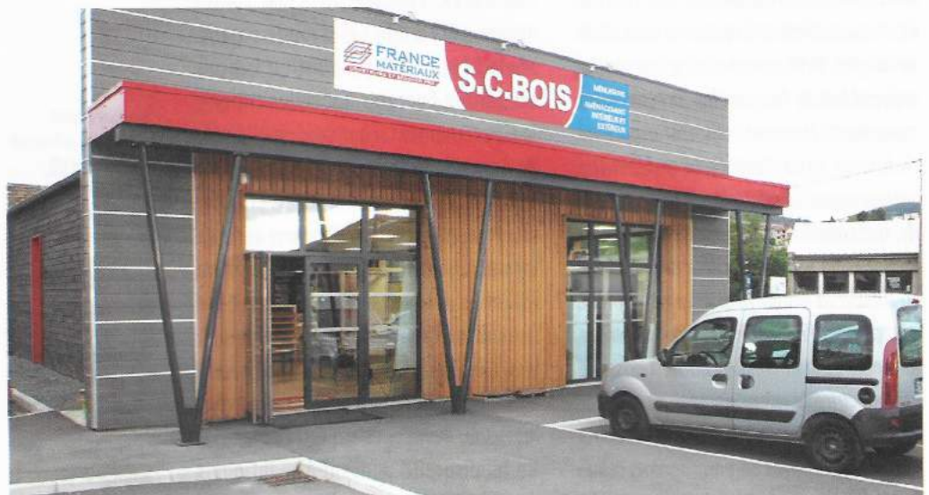
Le show-room flambant neuf de l'entreprise SC Bois est habillé d'un bardage en mélèze.
