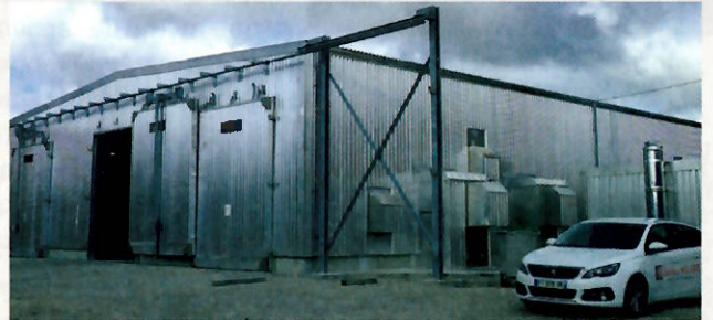
Vue extérieure sur le séchoir Cathild grande capacité et basse température.
