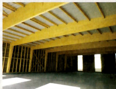
Le bâtiment de 700 m 2 qui va accueillir les bois séchés.
