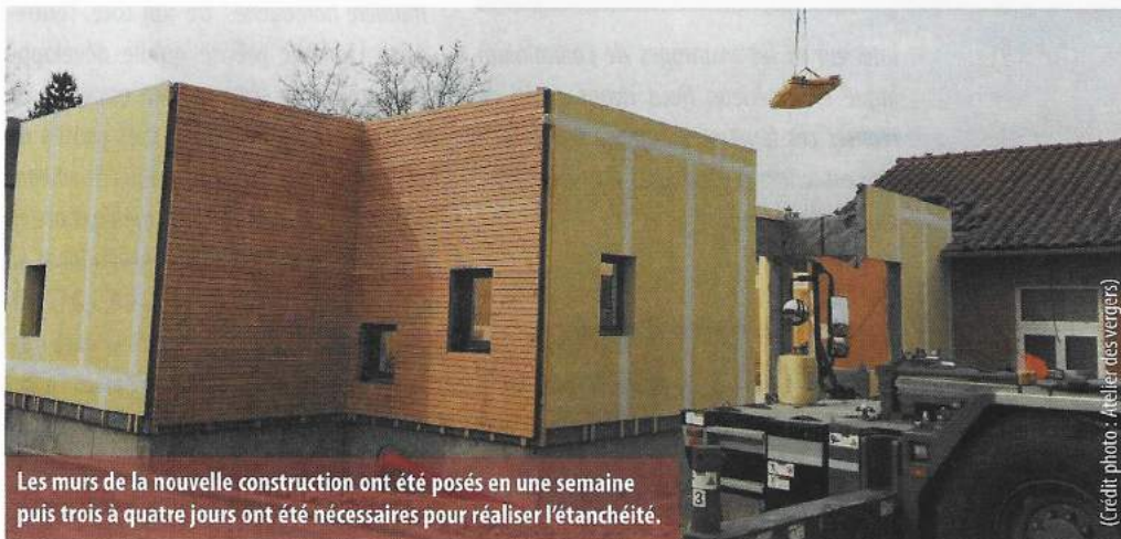
Le concept Lignatech avec murs porteurs en CLT cloués et les prédalles Lignadal utilisées ici en toiture, qui peuvent permettre de franchir jusqu'à 8 à 9 mètres de portée sans poteau intermédiaire.
