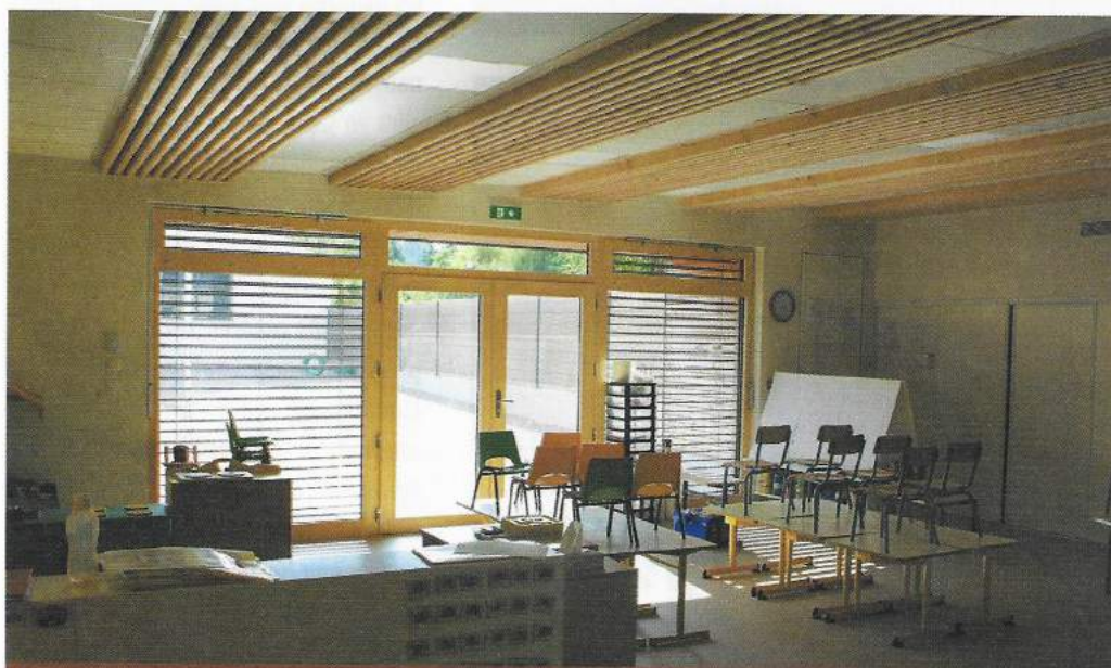
Les prédalles en sapin/épicéa ont volontairement été laissées visibles au plafond des salles de classes. Le système de chauffage et l'éclairage ont été intégrés entre les poutres.
