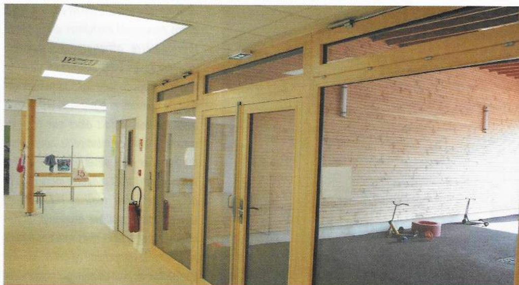
Le bâtiment est équipé de menuiseries mixtes bois/alu fabriqués en épicéa par l'entreprise Meunier-Marnat.
