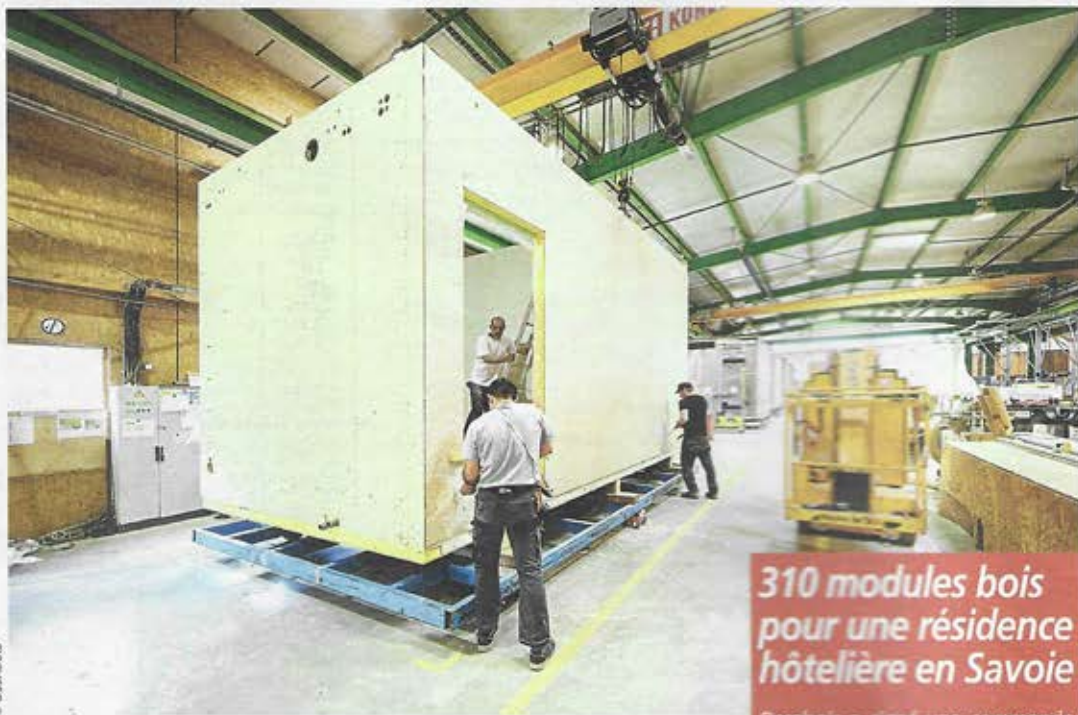
Cette nouvelle usine, de 6 000 m 2 équipée de 2 000 m 2 de zone de stockage, a été conçue sur l'ancien site industriel Samro
