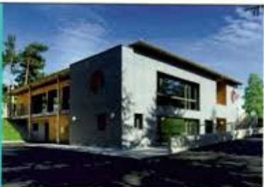
ESA de Chambéry (42) - Architecte : Atelier des Vergers - Photo : P. Hennouet
