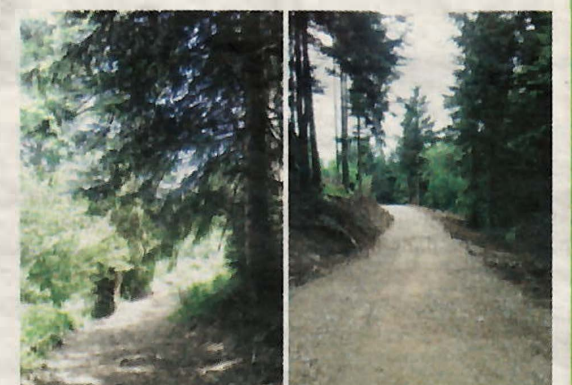
Avant... Après... le travail d'entretien des dessertes forestières
