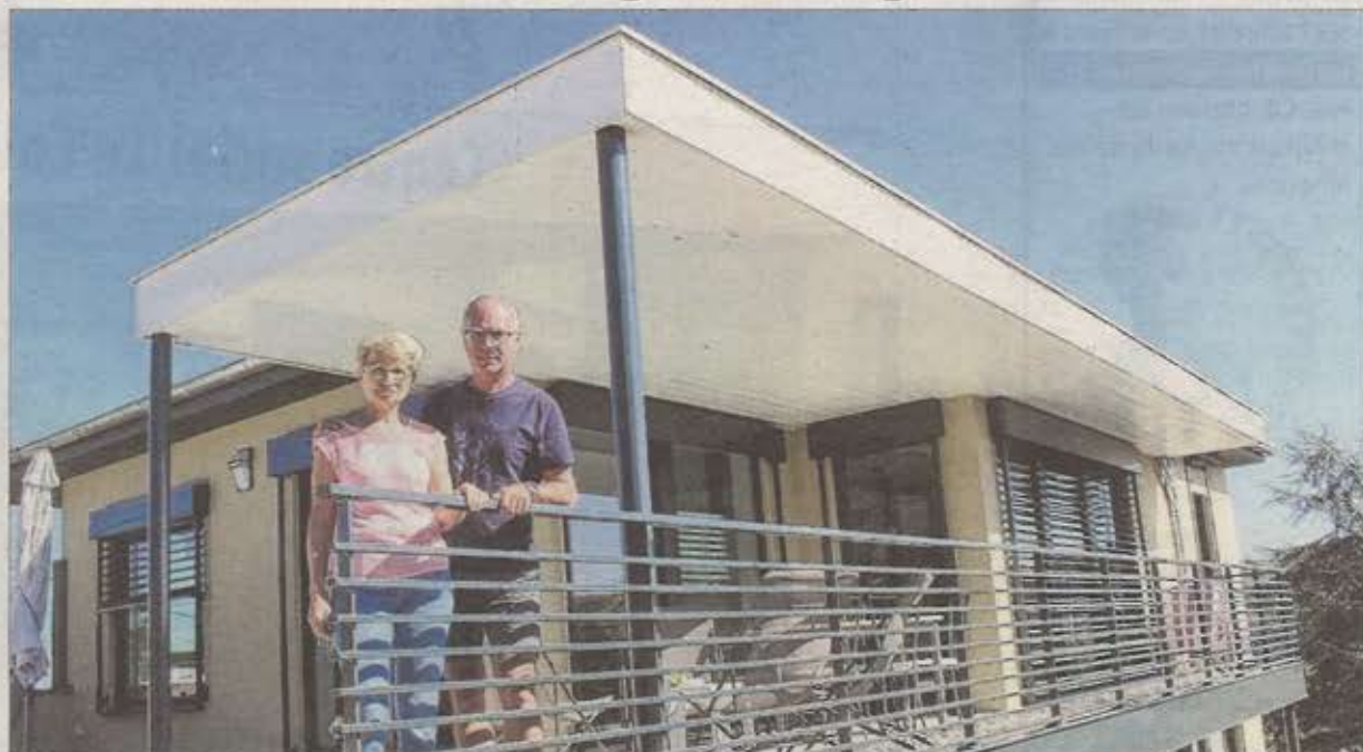
■ Marie-Claire et Pierre Ojardias dans leur maison passive de Villerest. Photo Kevin TRIET
