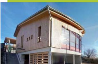
2% de surinvestissement pour un bâtiment en bois par rapport aux variantes maçonnées permettent des réductions de 19% sur les émissions de CO<sub>2</sub> et de 7% sur l'énergie grise. La proportion importante de béton due au soubassement limite les réductions
