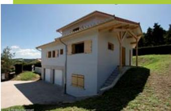
En ne dépassant pas un surinvestissement de 2%, le bâtiment bois arrive à réduire les émissions de gaz à effet de serre de 54% et l'impact énergie grise de 11% par rapport aux modes constructifs conventionnels
