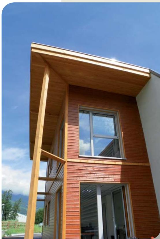
Relié à l'atelier par un mur coupe-feu en béton préfabriqué, le bâtiment de bureaux érige ses deux étages d'ossature bois en se dotant de performances thermiques remarquables.
