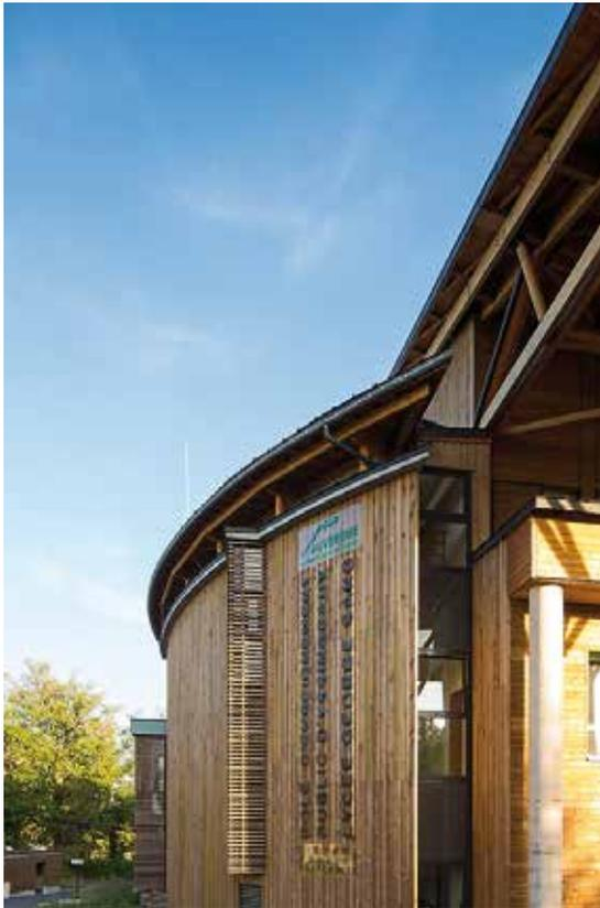
Le projet, dans un premier temps, a déposé l'ancienne toiture, puis créé une structure en béton de type portique-pont, qui traverse l'ensemble de la construction. Par surélévation en bois et sur ce squelette de béton s'élèvent désormais deux niveaux comportant salles de classe et internat.
