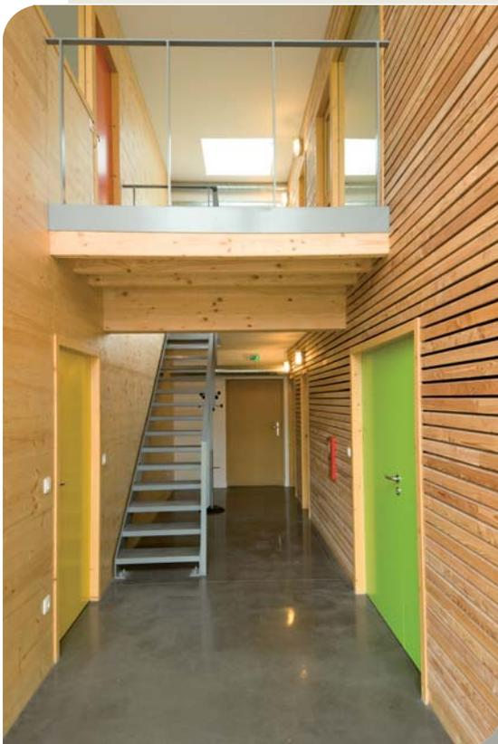
Un volume simple et compact, des espaces dimensionnés au minimum, des matériaux laissés bruts, des éléments techniques laissés apparents comme les gaines de ventilation..., voilà les principes d'économie envisagés lors de la conception du bâtiment. La brillance apportée par la finition lustrée des dalles et les transparences de la partie centrale augmentent l'impression d'espace sans m<sup>2</sup> supplémentaires !
