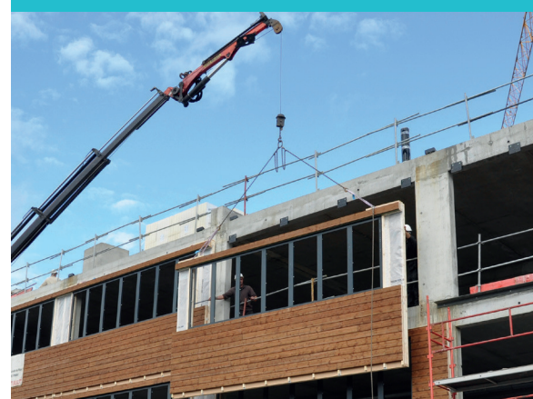
Pose d'un pan de mur préfabriqué pour le bâtiment du SIEL-TE à Saint-Priest en Jarez (42).
