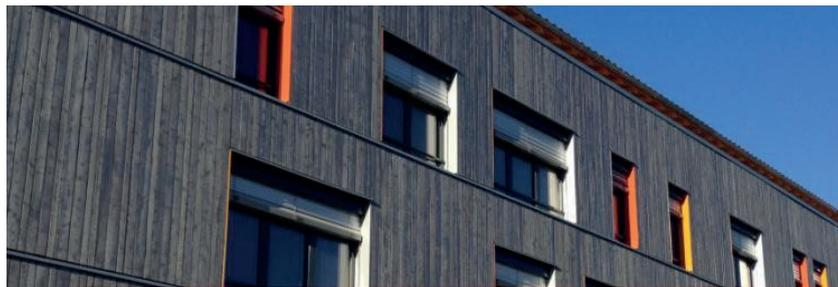
Antenne du Département de la Loire - arrondissement de Montbrison (42) avec un bardage pré-grisé. Architecte : Atelier des Vergers et Agence SARM.
