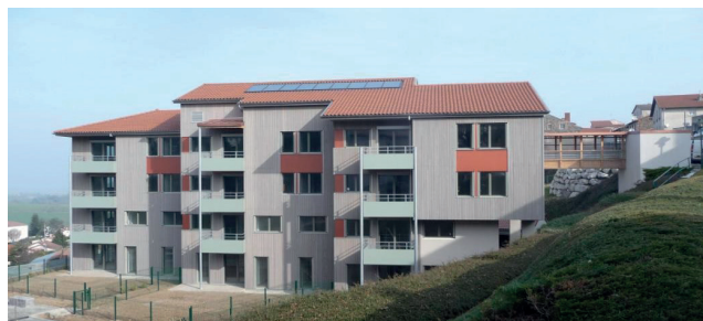
Logements sociaux passifs en bois La Galachère à Saint-Héand (42). Architectes : Ateliers des Vergers et Agence SARM.
