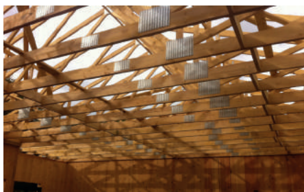
Logements à La Grand'Croix (42). Architecte : Alain Coumert.
