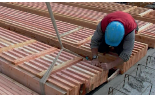
Mise en œuvre plancher Lignadal®.
