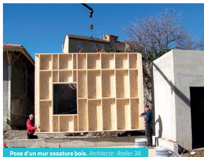
Pose d'un mur ossature bois. Architecte : Atelier 3A.
