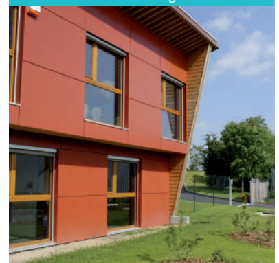
Résidence d'entreprises à Neulise (42). Architecte : Atelier des Vergers.
