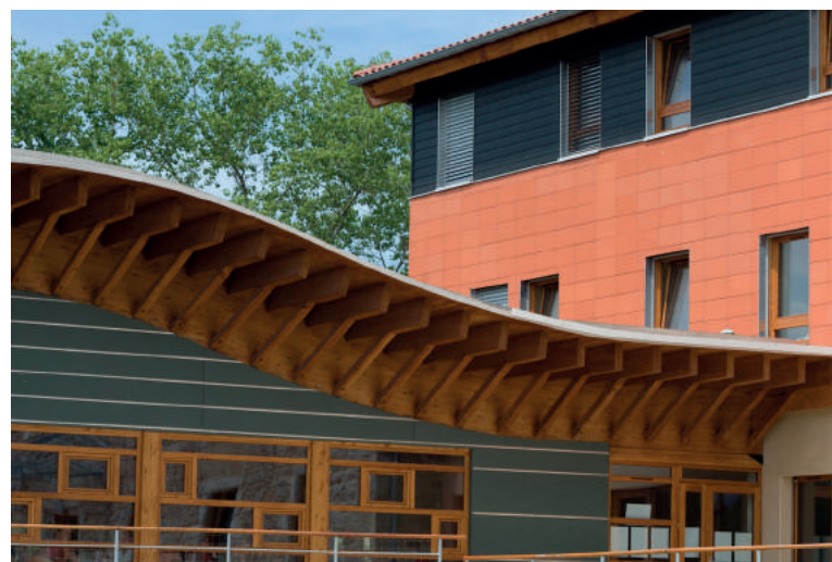
Foyer d'accueil, Les Salles (42). Architecte : Archipente et Atelier des Vergers.
