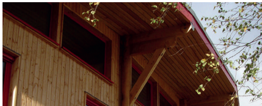
Les débords de toiture permettent de protéger les façades et limiter le grisonnement. Architecte : Atelier 3A.
