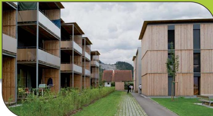
Les balcons autoporteurs, désolidarisés de la structure, suppriment un pont thermique
