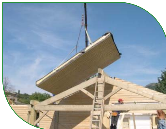
Pose de panneaux de toiture isolés
