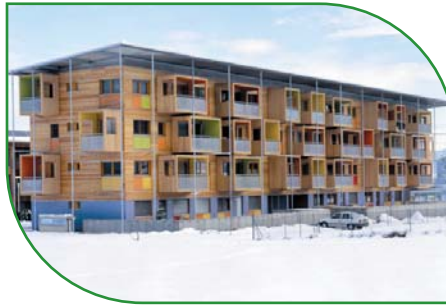
Immeuble R+3 en panneaux massifs
