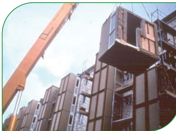
Exemple de levage d'un module tridimensionnel
