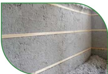
Utilisation d'isolants à forte capacité thermique (ouate de cellulose, fibre de bois dense) sur les parois les plus ensoleillées.
