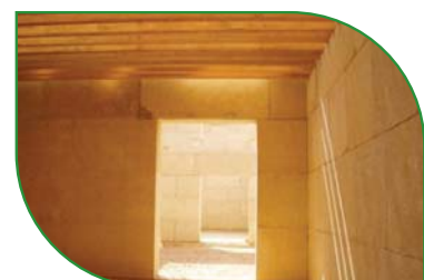
Renforcement de l'inertie thermique par des matériaux lourds dans les dalles, les cloisons et les murs de refends
