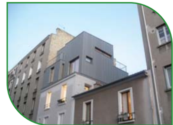
Surélévation d'un immeuble à Paris en panneaux massifs. Chantier rapide, poids de la surélévation faible...
