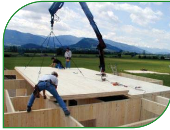
Exemple de chantier en panneaux massifs
