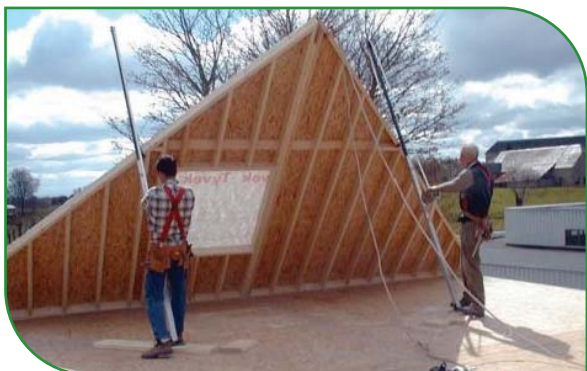
Exemple de levage de panneaux fabriqués sur chantier
