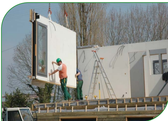
Pose de panneaux préfabriqués avec isolation, menuiseries extérieures, et parement intérieur
