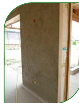
Ajout d'un enduit chaux-sable (5 cm) en doublage intérieur des murs ossature bois.
