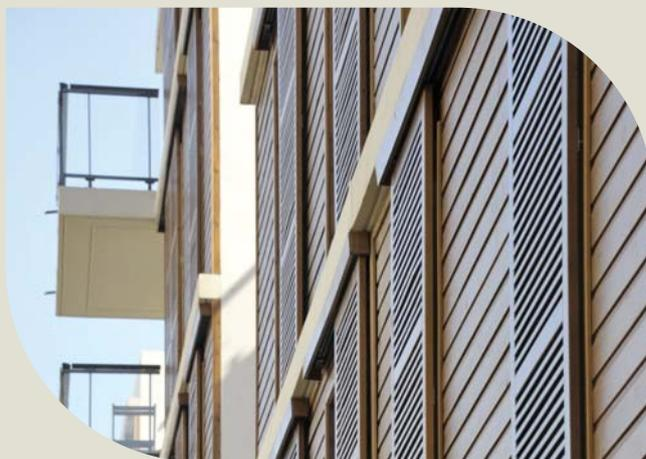
La construction bois est unanimement reconnue pour ses hautes performances en hiver, dans les bâtiments à très basse consommation d'énergie. Néanmoins, ce système constructif véhicule aussi une image de bâtiment à faible inertie, au confort d'été mitigé. Pourtant, il est important de comprendre que l'inertie n'est ni le seul, ni surtout le principal paramètre qui influe sur le confort d'été.
