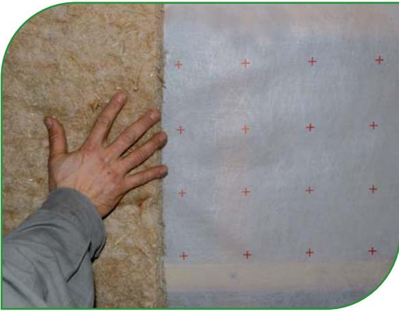
**Pose d'une couche d'isolant coté intérieur de la membrane d'étanchéité à l'air**
