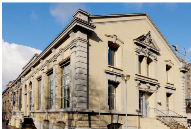
Réhabilitation d'un bâtiment en bureaux Saint-Étienne (42)
